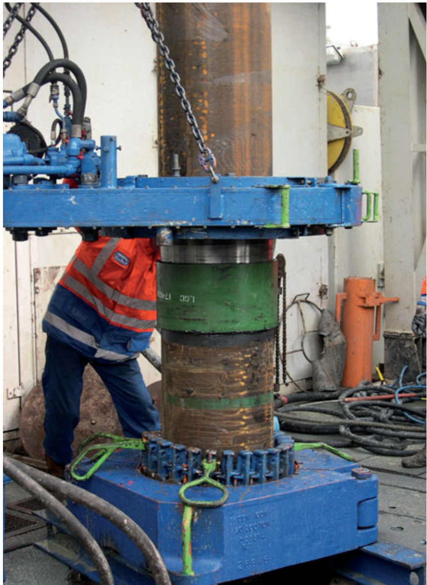
Abb. 9 Verschrauben der 13 3/8“-Casing-Rohre
