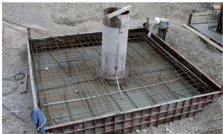
Abb. 5 Fundamentarbeiten am Bohrkeller mit gesetztem Standrohr
