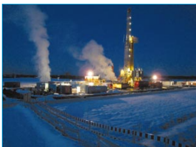
Drilling rig in Unterföhring ■
