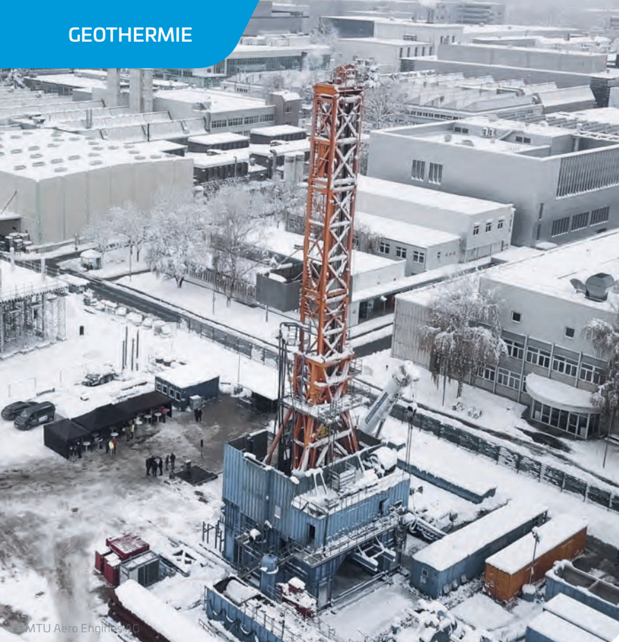
Bohrturm vor dem MTU-Werksgelände zum Projektstart Anfang Dezember 2023.
